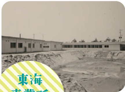
建設中の東海清風園
