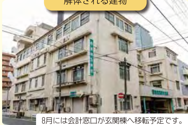
解体される建物
