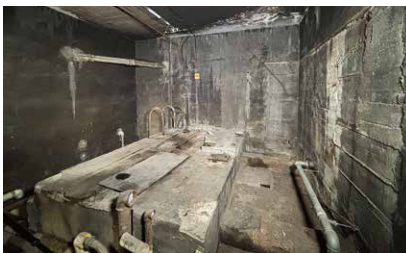
空襲で焼け残った外来棟西館最上階の小部屋
