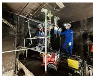
煤のついた天井の切り出し作業
