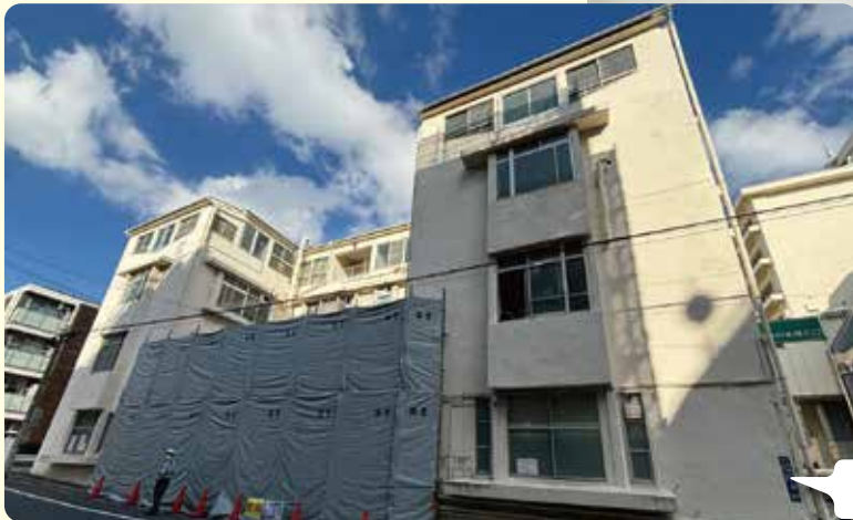
解体準備が進む外来棟西館の西側
