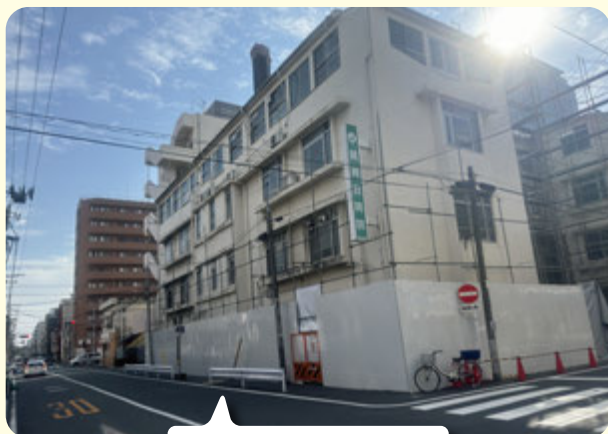
【外来棟西館解体前】
