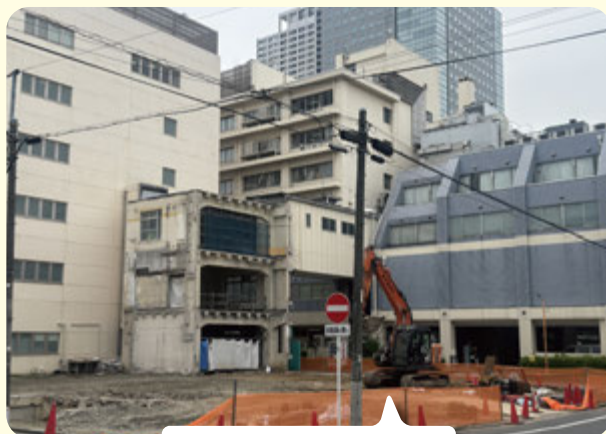
【外来棟西館解体後】
